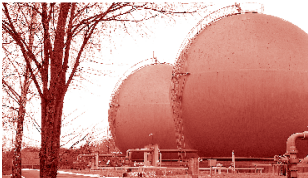
Erdgas wird auf dem Gelände der Erdgas Ostschweiz AG in Zürich-Schlieren vor der Weiterverteilung in das Versorgungsgebiet in Hochdruckgaskugeln gelagert. Christine Bärlocher / ex-press.ch
